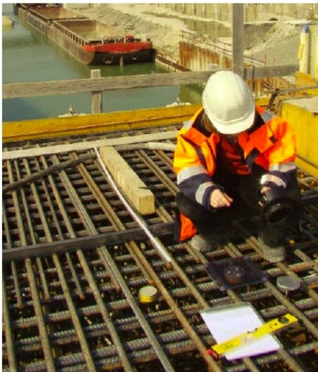
Standard-Installation Sensor Typ C
